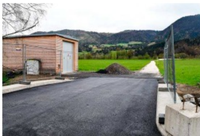
Die Erschließung für die geplante Jausenstation ist teilweise schon geschehen. Über den Brunnbach wurde eine neue Brücke gebaut. Foto: Monitzer
